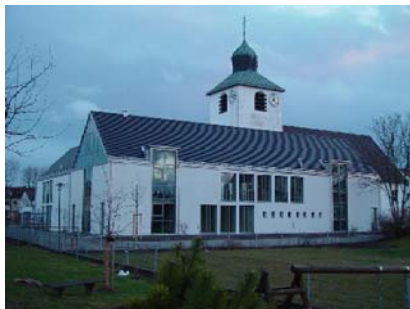
Ansicht von Norden
